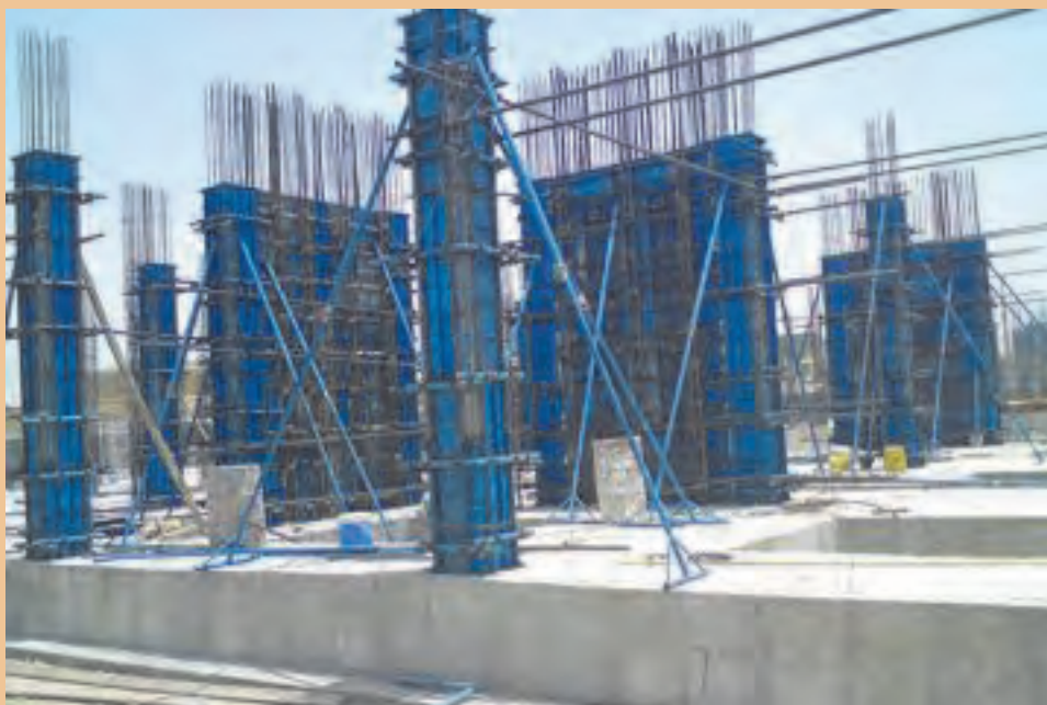
قالب‌بندی و آرماتوربندی ستون
